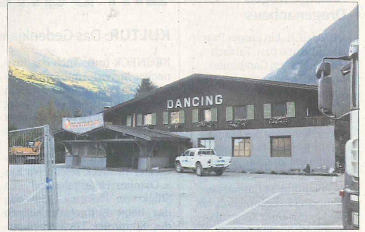
In diesen Tagen wird die ehemalige Diskothek Sportcenter abgerissen mt
